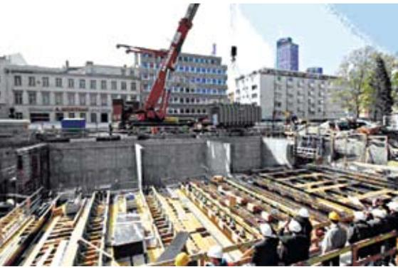
**Neubau des Umspannwerks Hochstraße, Frankfurt, für die Mainova AG. Einbau eines von drei Transformatoren mit einem Gewicht von 85 Tonnen.**
