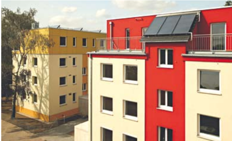
Die Wohngebäude der ABG-Holding in der Tevesstraße sind ein Beispiel dafür, dass auch bei einer Sanierung ein Passivhausniveau erreicht werden kann
