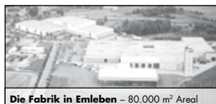
Die Fabrik in Emleben – 80.000 m² Areal
