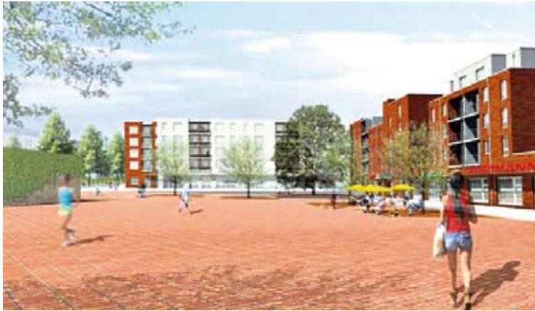
Die Gebäude sind jeweils dreigeschossig zuzüglich Staffelgeschoss. Die Wohnungen verfügen über einen Balkon beziehungsweise Terrasse und sind über einen Aufzug erreichbar
