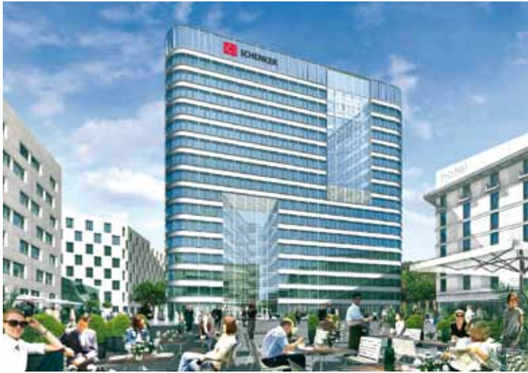
Gebäudekomplex Alpha Rotex: Baubeginn noch dieses Jahr»
