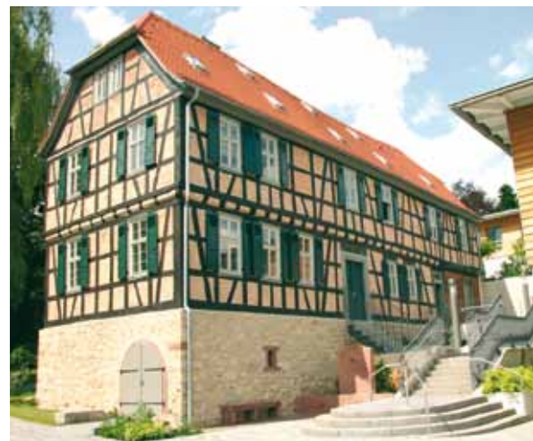
Im vergangenen Jahr wurde die „Alte Mühle“ in Enkheim erfolgreich saniert Bildquelle: Denkmalamt
