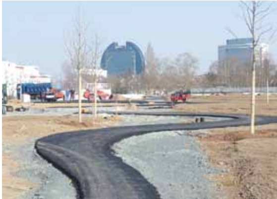
Baustellenansicht im nördlichen Taschenpark
