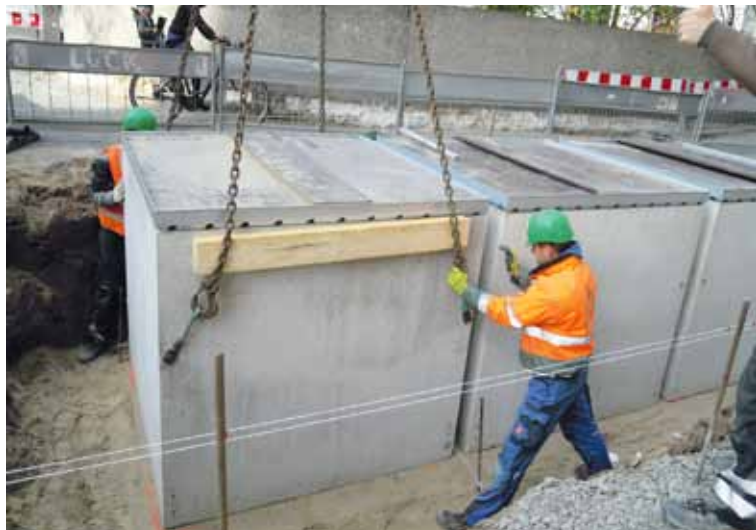
Die Unterflur-Glascontainer beim Einbau am Martin-Luther-Platz
