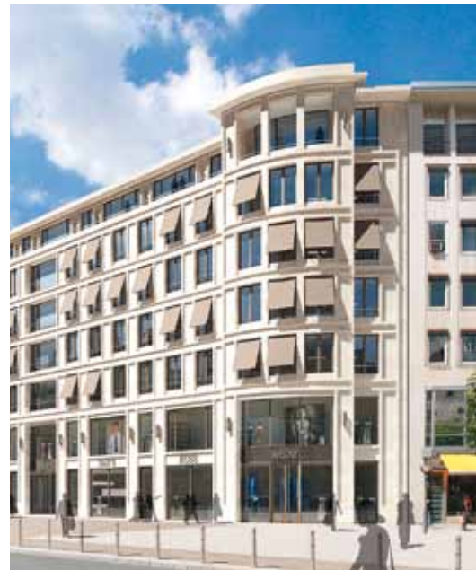
Neubau Hansainvest: Geplante Fertigstellung Ende 2013
