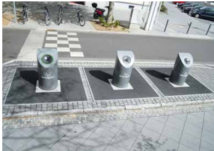
Die neuen Unterflur-Glascontainer nach Fertigstellung
