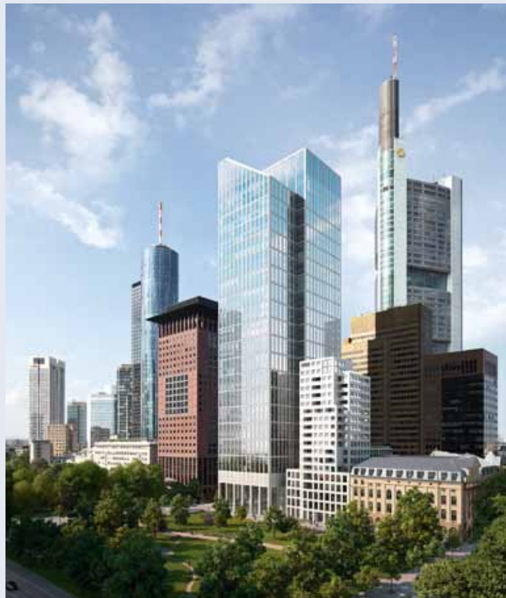
Der TaunusTurm, der bis Ende 2013 fertiggestellt werden soll, wird sich als erstes Gebäude an der Neuen Mainzer Straße zur Wallanlage hin ausrichten
