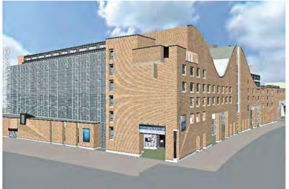
Das Gebäude der ehemaligen Stadtwerke, in das nun die Mitarbeiter des Technischen Rathauses eingezogen sind, in 3D-Ansicht
