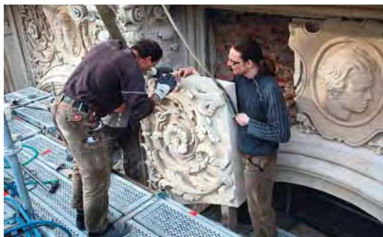
15 der bis zu 500 kg schweren Einzelteile der Reliefs oberhalb der Südterrasse wurden in die Fassade gehoben und dort verankert
