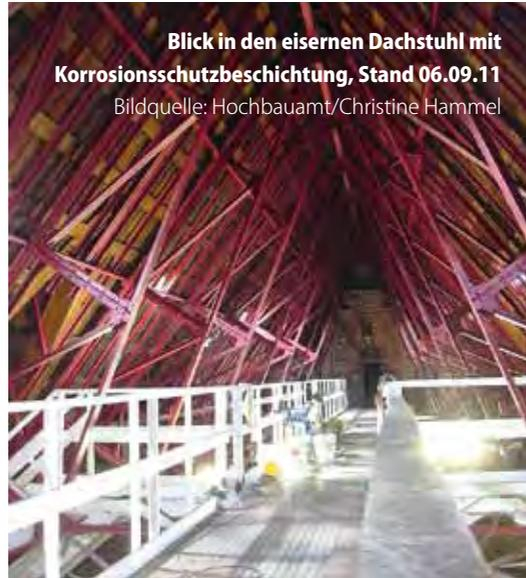
**Blick in den eisernen Dachstuhl mit Korrosionsschutzbeschichtung, Stand 06.09.11**
