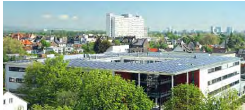
Schon umgesetzt: Photovoltaik-Anlage auf dem BiKuZ in Höchst
