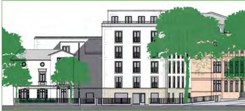
Zugang zur Kulturfabrik und dem Innenhof zwischen dem geplanten Neubau und der Backstein-Villa aus der Gründerzeit
