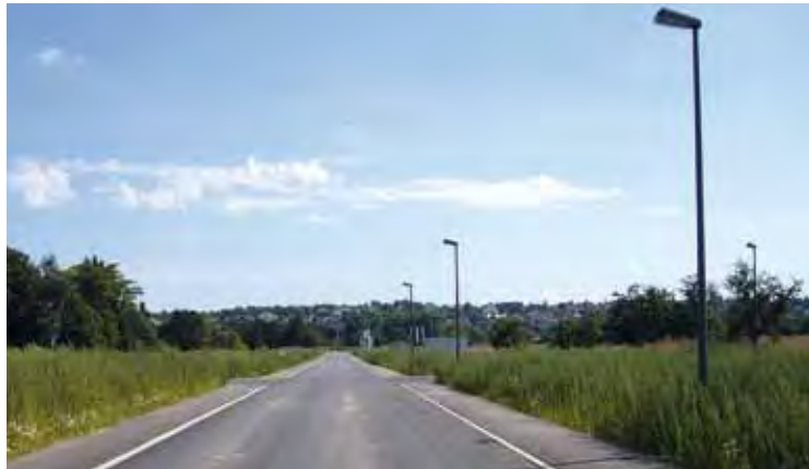
Fertiggestellte neue Straße „Im Niederfeld“ mit seitlich erschlossenen Baugrundstücken
