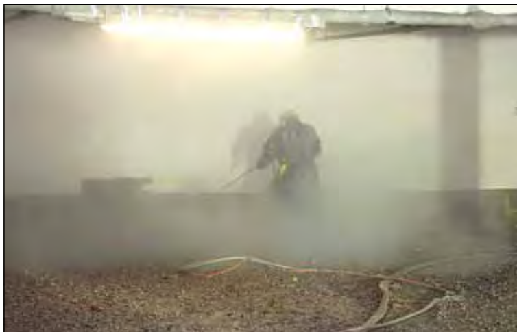
Betonsanierung mit einem modernen, geräuscharmen Höchstdruckstrahler im Parkhaus Dom Römer
