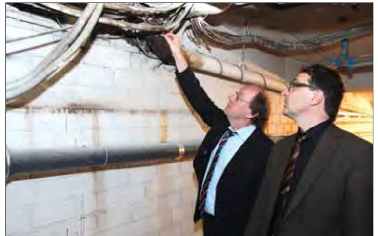
Korrodierte Leitungen, angegriffener Beton: Michael Guntersdorf und Projektleiter Robert Scheuerer im Parkhaus Dom Römer
