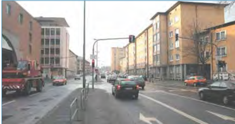
Die Kurt-Schumacher-Straße vor den Baumaßnahmen Bildquelle: Stadtplanungsamt
