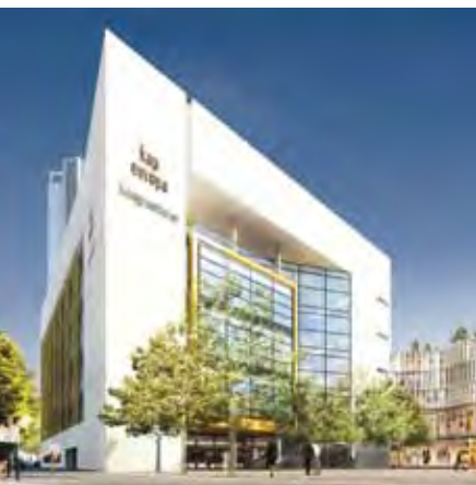
Der Eingangsbereich des neuen Kongresshauses
