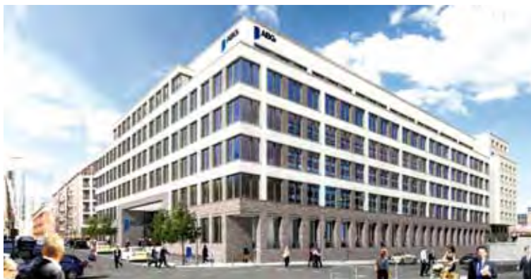
Die neue Unternehmenszentrale der ABG in der Niddastraße
