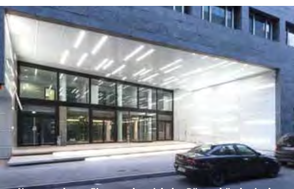
Neu gestalteter Eingangsbereich des Bürogebäudes in der Weserstraße 54 Bildquelle: KSP Jürgen Engel Architekten
