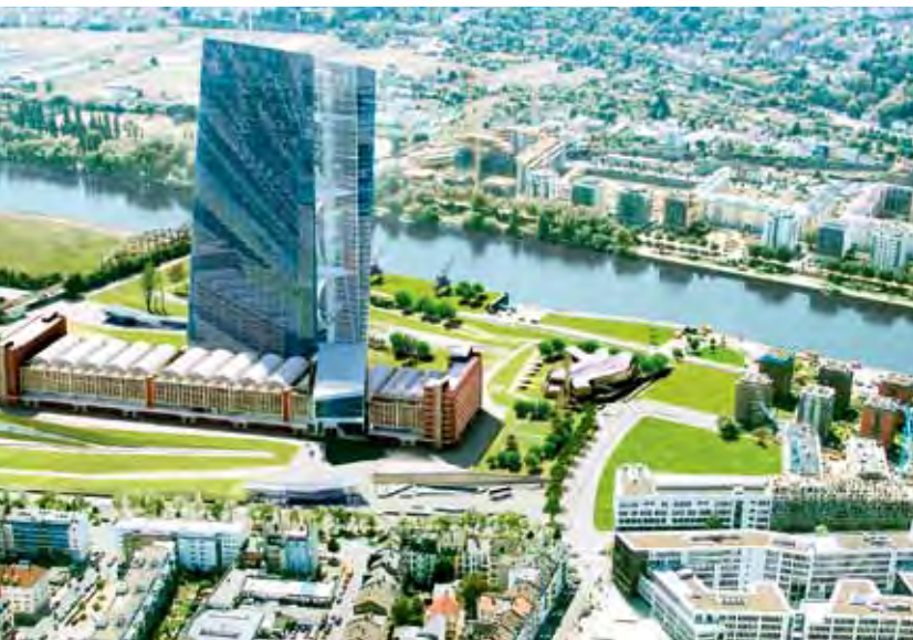
Neuer Juwel im Frankfurter Stadtbild: Der EZB-Gebäudekomplex
