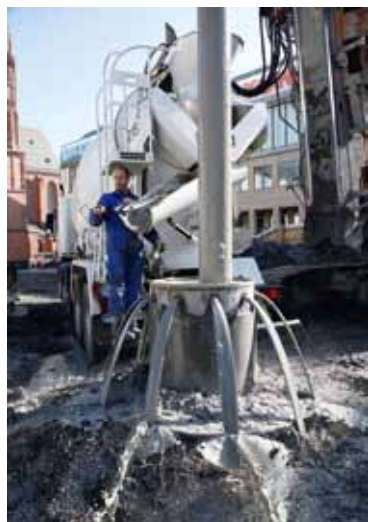
Setzen der Gründungspfähle für Stadthaus und südliche Häuserzeile am Markt. Der Archäologische Garten ist unter einer schützenden Schicht verpackt
