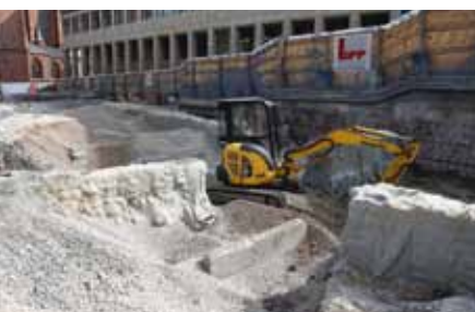
Vorsichtig wird das kiesartige Material entfernt
