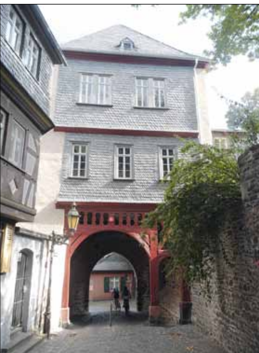
Schindelfassade an der Nordseite des Alten Zollturms
