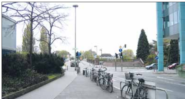
Neue Mainzer/Hofstraße: Umfassende Erneuerung des Kreuzungsbereichs an der Untermainbrücke steht bevor Bildquelle: Stadtplanungsamt
