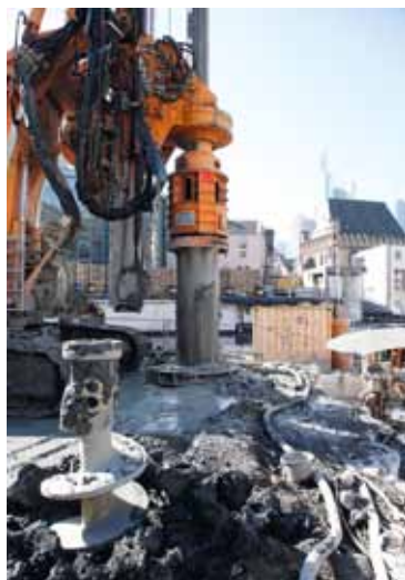
Setzen der Gründungspfähle für Stadthaus und südliche Häuserzeile am Markt. Der Archäologische Garten ist unter einer schützenden Schicht verpackt
