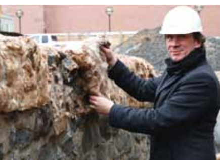
Projektleiter Matthias Leißner »ent-hüllt« die historischen Mauern. Das Vlies schützte sie während der Gründungsarbeiten
