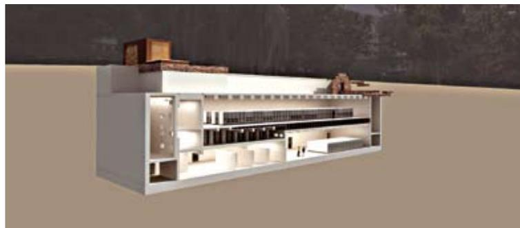
**Unterirdische Innovation: Eines der modernsten Umspannwerke Europas liegt zu 99 Prozent unter der Erde**
