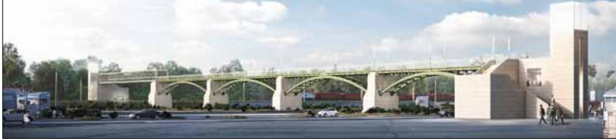
bahn von 1910 bis 1913. Die Brücke wurde im Zweiten Weltkrieg teilweise zerstört und 2011 wegen baulicher Mängel für den Fußgängerverkehr gesperrt. Das Entwurfskonzept sowie die geplanten Sanierungsarbeiten sollten unter Berücksichtigung der heutigen technischen und funktionalen Anforderungen die maximale Erhaltung der historischen Bausubstanz sowie die Wiederherstellung und Stärkung
